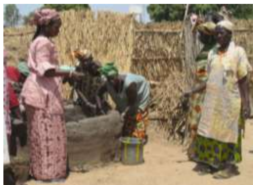
Construction d'un grenier à Dioral (Source Enda 2013)
