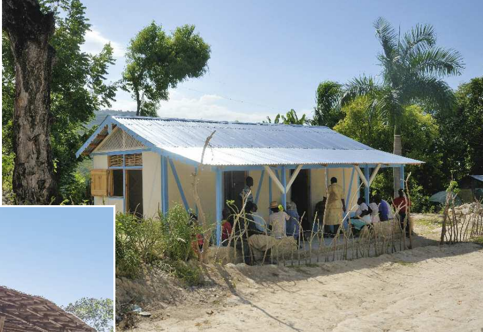
Haïti : Le bâtiment d'habitation, réalisé par les habitants eux-mêmes selon un mode de construction traditionnel et résistant aux tremblements de terre, est en ossature bois et le remplissage est effectué en pierres.
