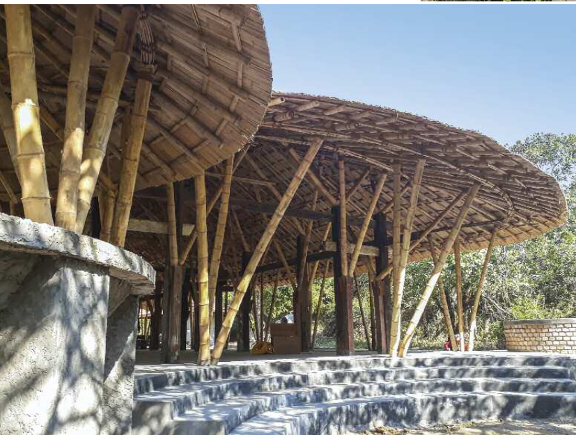
Myanmar : La salle polyvalente du centre, de 25 m de long et d'environ 6 m de haut, est un espace ouvert et perméable à l'air. Le bâtiment, entièrement construit en bambou, est recouvert de bardeaux en bambou.
