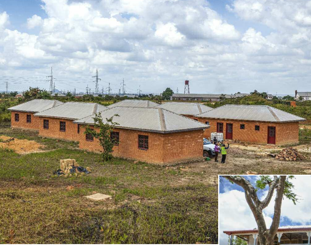
Congo : Le centre de formation a été construit en terre (briques de terre comprimée). Le matériau a été prélevé directement sur place.
