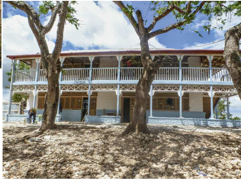
Haïti : L'école a été construite en utilisant un mélange de bois et de terre (ossature bois et remplissage avec des briques de terre crue). Le bâtiment est construit pour résister aux tremblements de terre.
