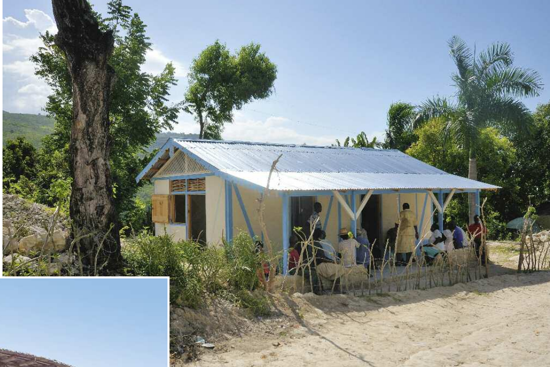
Haiti: A casa construída em mutirão é feita com armação de madeira tradicional preenchida com pedra natural e é resistente a terremotos.
